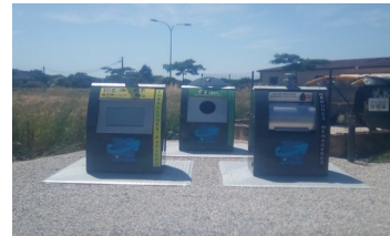
Enterrés au fond du parking de la salle des fêtes
