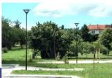
Maintenance et travaux d'éclairage public
