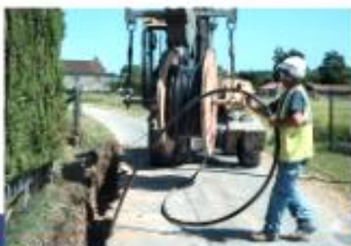
Contrôle et aménagement des réseaux d'électricité et de gaz
